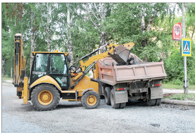
Идет ремонт дороги по ул. Калинина
