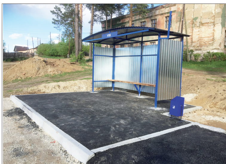
Новый остановочный комплекс на ул.Культуры.
