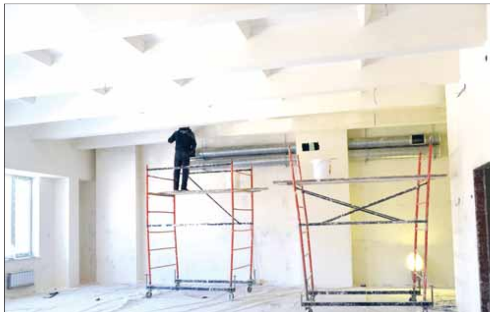
Продолжается чистовая отделка помещений
